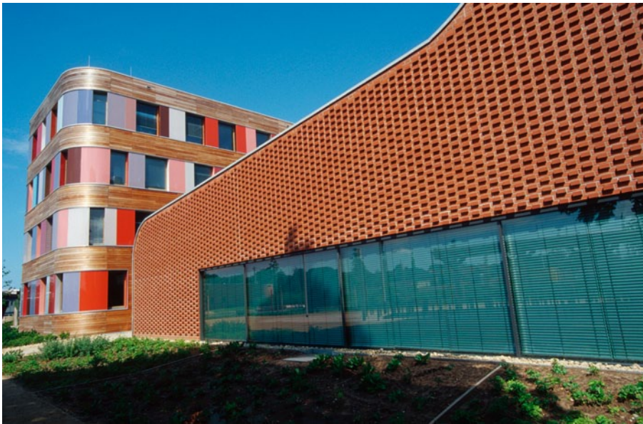
Umweltbundesamt in Dessau Konstruktionen der Außen- und Innenfassade aus Holz gebaut
